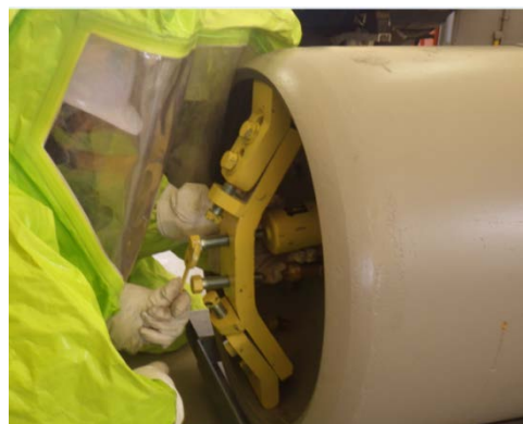
塩素ガス容器への漏洩止具取付
